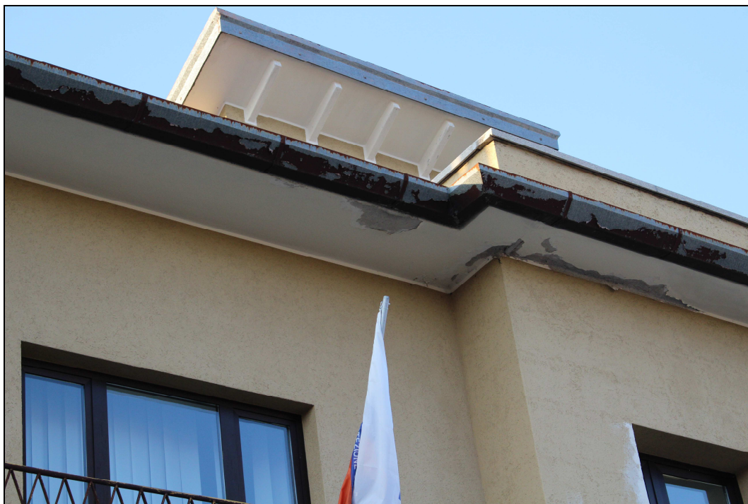
Foto grondaie/linda con intonco ammalorato
