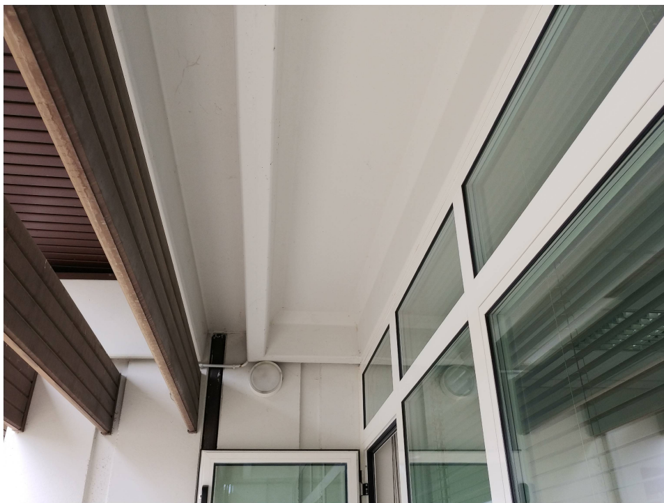
Foto 6 – Vista esterna delle travi in c.a. prefabbricate.
