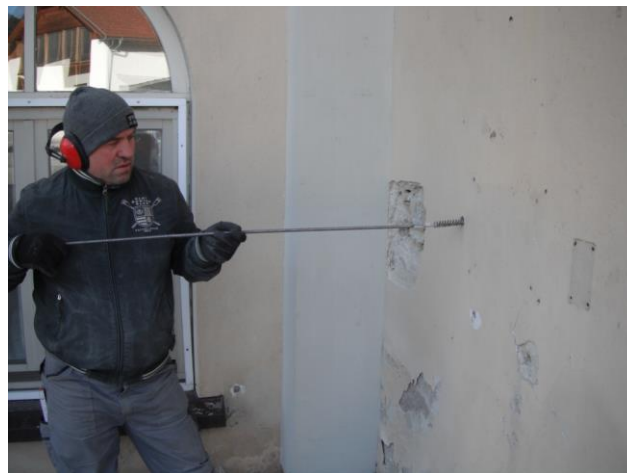
Perforazione per videoispezione e pulizia del foro
