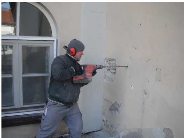
Perforazione per videoispezione e pulizia del foro
