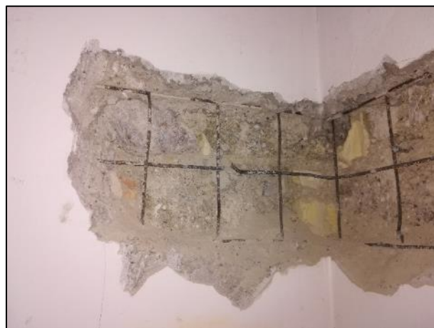
Fasi delle microdemolizioni.
