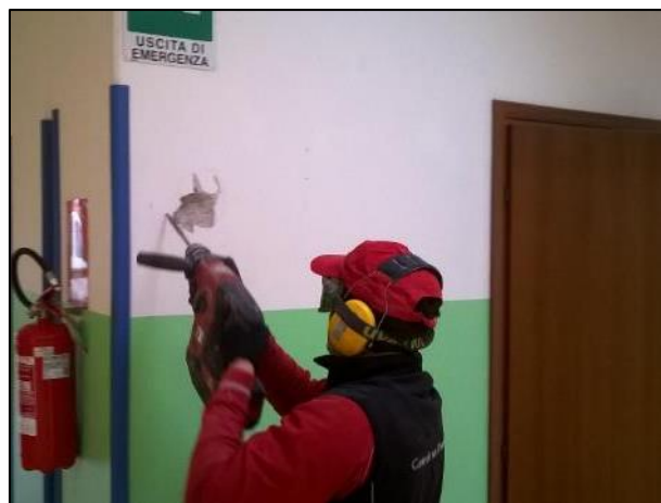
Una fase dei rilievi pacometrici e delle microdemolizioni
