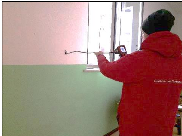
Due fasi dell'indagine videoendoscopica sulle murature.
