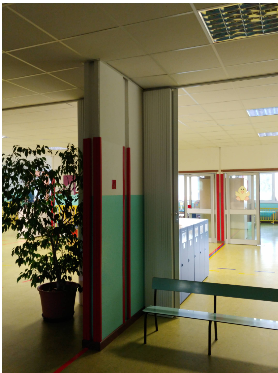
Foto 5 – Vista interna. Pilastri in c.a. e controsoffittature.
